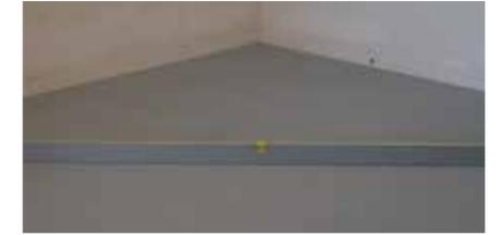
Vor Verlegung ist die je nach Estrichtyp maximal zulässige Restfeuchte (z.B. Zementestrich 1,8CM%, Anhydrit-Estrich 0,3CM%, etc.) durch Messung zu überprüfen. Funktionsfugen des Unterbaus (Estrich- u. Gebäudetrennfugen) sind zu übernehmen. Ebenso sind grundsätzlich auch Dehnungsfugen zwischen Räumen vorzusehen. In Abhängigkeit der Raumgeometrie können zusätzliche Dehnungsfugen erforderlich sein.
