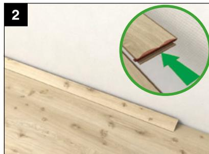
Die kopfseitige Kunststofffeder wird wieder in die Kopfnut zurückgeschoben und danach wird die Diele längsseitig in die vorletzte Reihe eingewinkelt.
