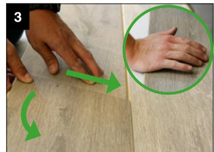
Die Diele wird flach bis an die Längsseite geschoben, dabei die gesamte Reihe anheben und linke Diele einrasten.
