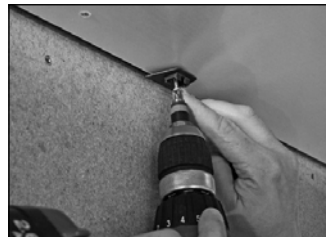
Leistencap montieren
