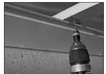
Befestigungskralle anschrauben
