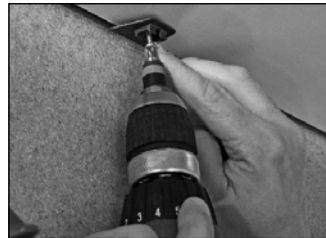
Leistencap montieren
