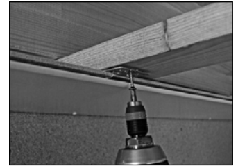
Befestigungskralle anschrauben
