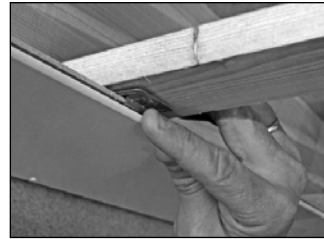
Befestigungskralle setzen
