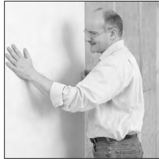
Einsetzen erste Platte
