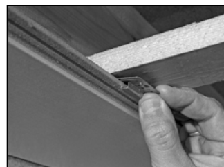
Befestigungskralle setzen
