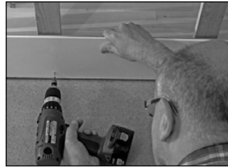
Erstes Steck-Paneel befestigen
