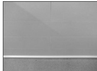
Deckenabschlussleiste aufstecken – fertig
