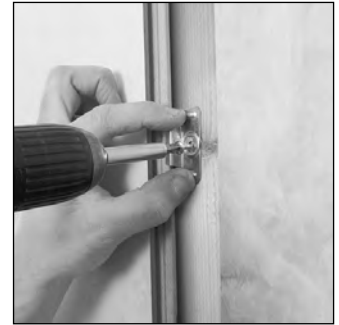
Mittelklammer setzen
