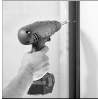
Befestigungsschiene setzen
