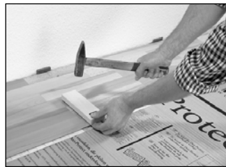
Fügen Sie die Kopffugen mit einem Hammer und Schlagschutz zusammen. Die Längs- und Kopffugen verriegeln dabei automatisch. Diese Verlegung im ganzen Raum fortsetzen.
