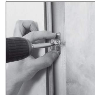
Mittelklammer setzen
