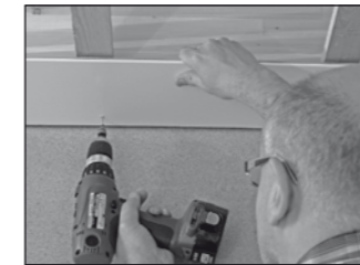
Erstes Steck-Paneel befestigen
