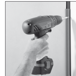
Befestigungsschiene letzte Platte
