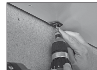
Leistenclip montieren
