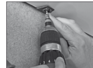
Leistenclip montieren
