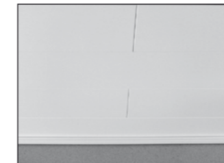
Deckenabschlussleisten aufstecken fertig
