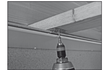
Befestigungskralle anschrauben
