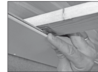
Befestigungskralle setzen
