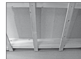
Unterkonstruktion
