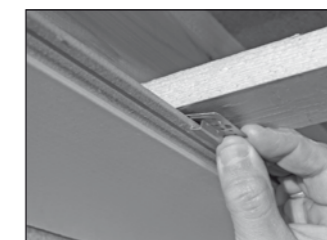
Befestigungskralle setzen
