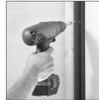
Befestigungsschiene setzen
