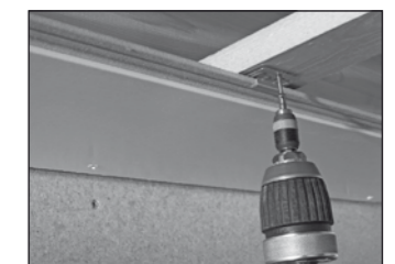
Befestigungskralle anschrauben
