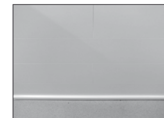
Deckenabschlussleisten aufstecken fertig
